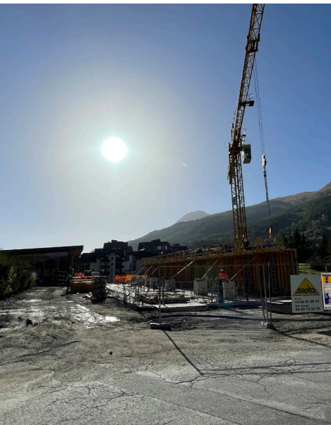
Construction de la maison de Santé
