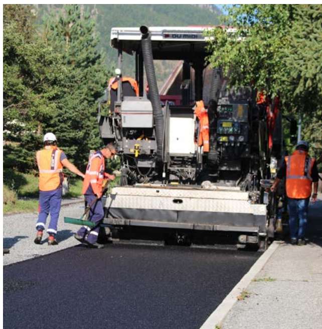
Réfection des enrobés (Montée de l'Aravet, Parking de l'entrée de la Salle, Points DSE Alpes d'Azur, Chemin de l'Amandier, Chemin de l'Oratoire, Route de Pré-Long, Berges de la Guisane, Entrée de la rue de la Guisane)
