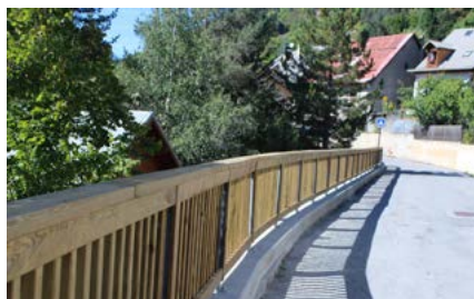
○ Remplacement de la barrière en bois, Chemin des écoles
