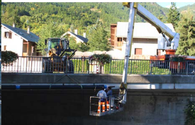
○ Réparation de la conduite d'eau, Pont Agel
